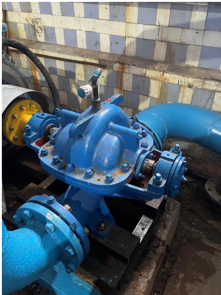
ЦЕНТРОБЕЖНЫЙ НАСОС 1Д 315-71 СОВМЕСТНО С ЭЛЕКТРОДВИГАТЕЛЕМ, НА ЦЕНТРАЛЬНЫЙ ВОДОЗАБОР
