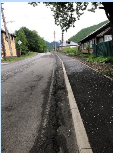
Устройство тротуара по ул. Парижской Коммуны
