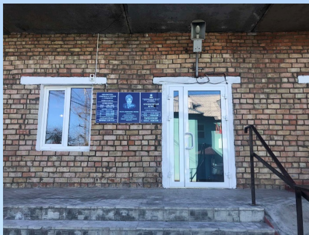
Капитальный ремонт ремонта помещения библиотеки семейного чтения по улице Фрунзе дом 8
