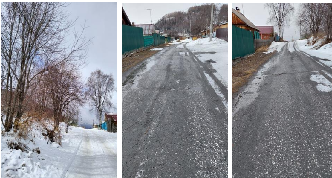
Рисунок 2 – Фото автомобильной дороги по ул. Линейная п. Сухой Ручей
